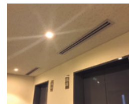
共用部の空調新設
