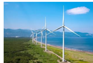
リエネ銭函風力発電所 (北海道小樽市)
